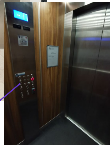
Boutons ascenseurs accessibles PMR et indication sonore des étages
