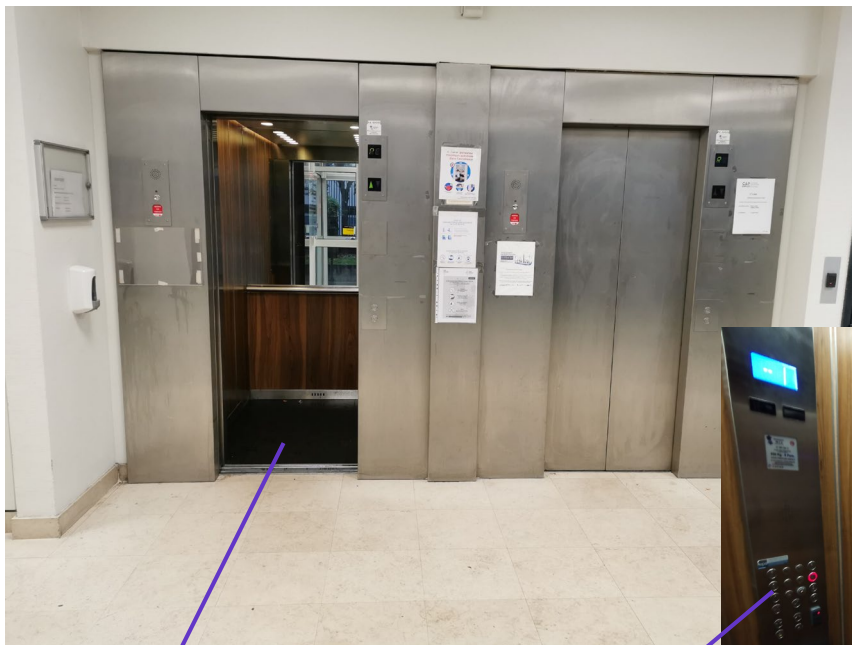
Boutons ascenseurs accessibles PMR et indication sonore des étages
