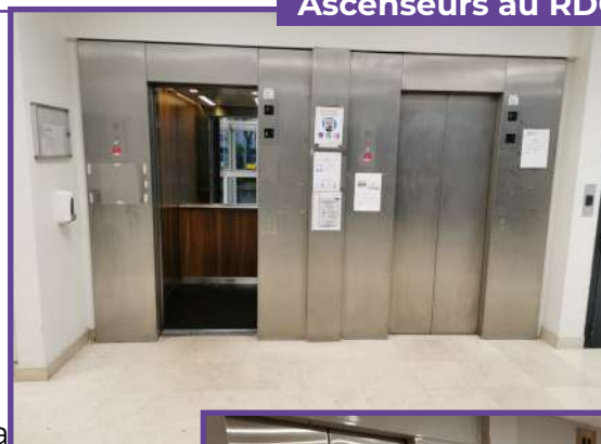
Ascenseurs au RDC
